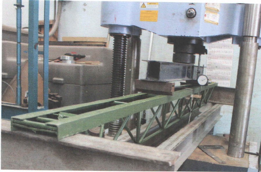
Figura 1-4 Montaje de la cercha – Cercha 1, L=3.0 m
